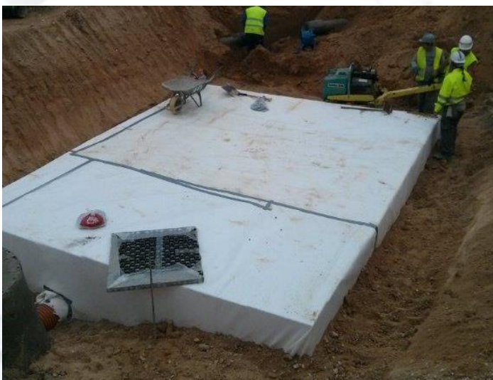
Depósitos para almacenamiento e infiltración de aguas pluviales. Cuentan con tubería de rebose para verter al saneamiento en caso de ser necesario.
