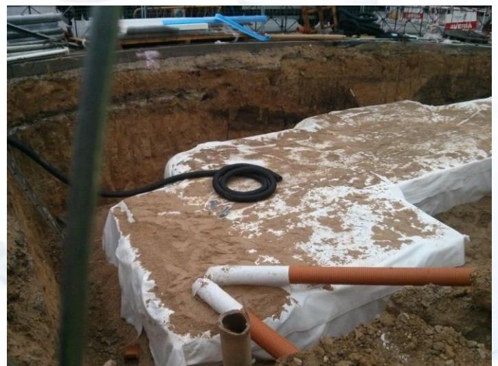
Depósitos para almacenamiento e infiltración de aguas pluviales. Cuentan con tubería de rebose para verter al saneamiento en caso de ser necesario.
