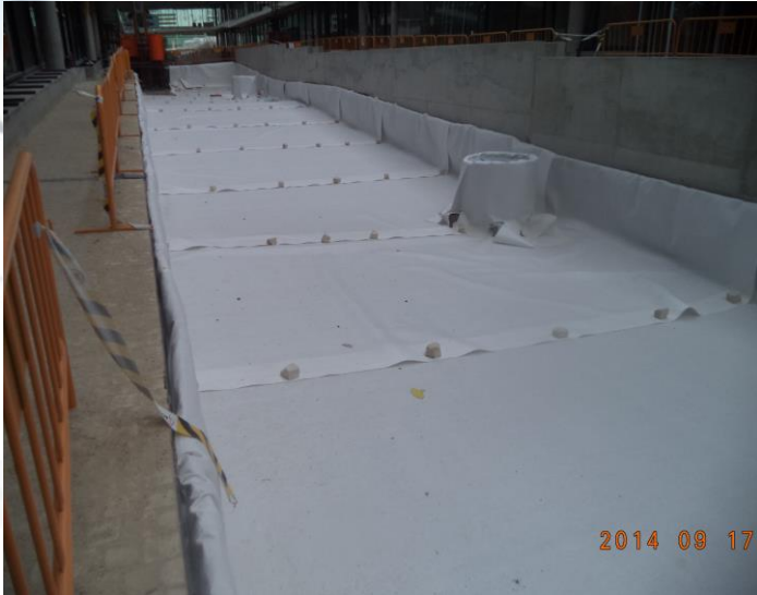
Celdas Atlantis bajo pavimento permeable, envueltas en geotextil.
